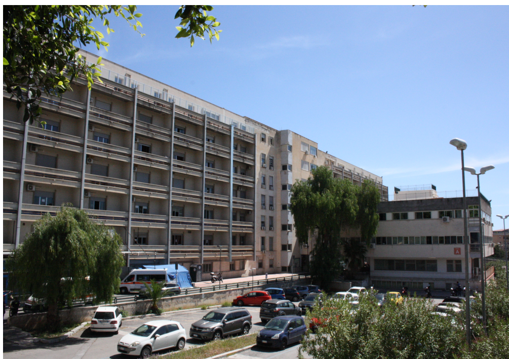
Fig. 13 - Vista del fronte Sud del Padiglione A, edificio “lineare multipiano” realizzato negli anni '80
