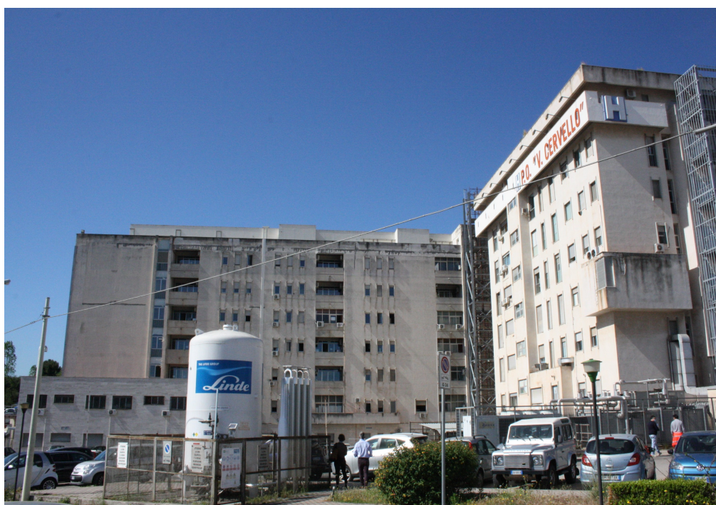
Fig. 14 - Vista del fronte Nord del Padiglione A
